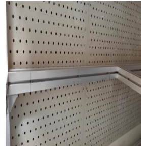
图 6 层板安装细节
